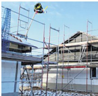
Das Diakoniewerk Neues Ufer baut altersgerechte Wohnungen. FOTO: KARSTEN
