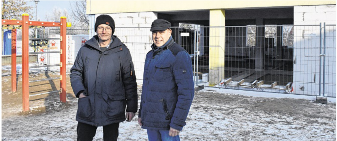
Die Arbeiten nehmen Gestalt an: Im Mai sollen die neuen Räume für den Hort fertig sein. Matthias Eberhardt und Detlef Wessels (r.) sind zuversichtlich. FOTO: MÜLLER
