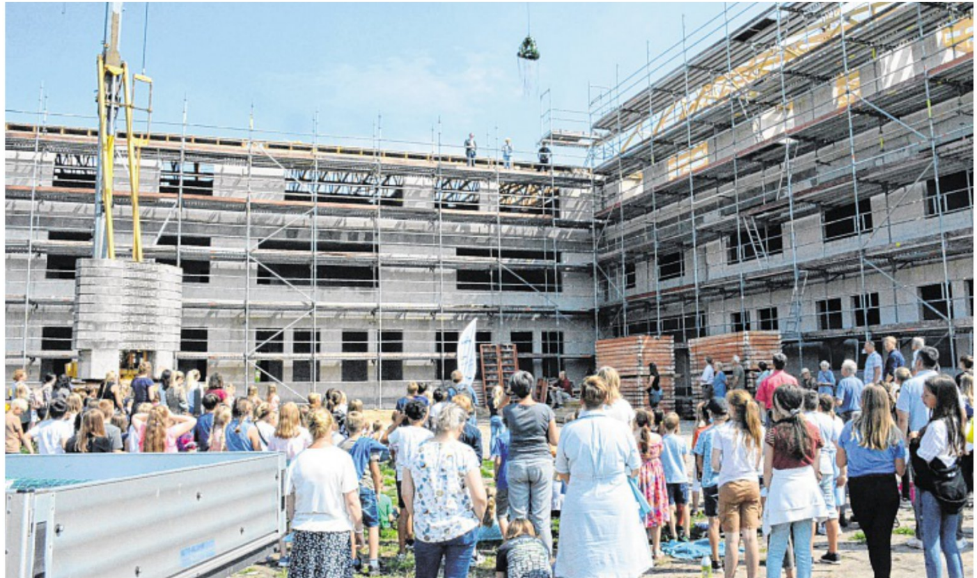
Die Mauern stehen, der Dachstuhl ist fertig. Am Donnerstag wurde für den Neubau der Edith-Stein-Schule in Ludwigslust Richtfest gefeiert.
